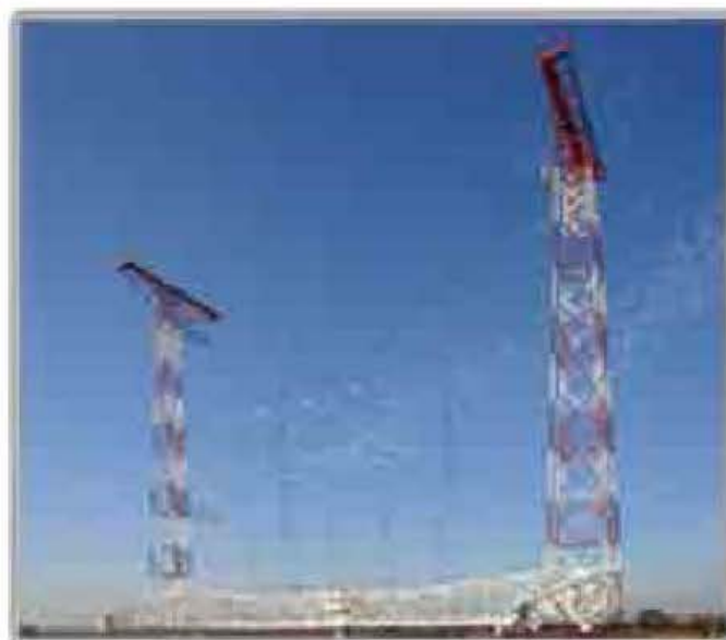
Moosbrunn SW Antenna
